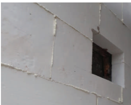
Fig. 7.4 - Izolare termică a pereților
